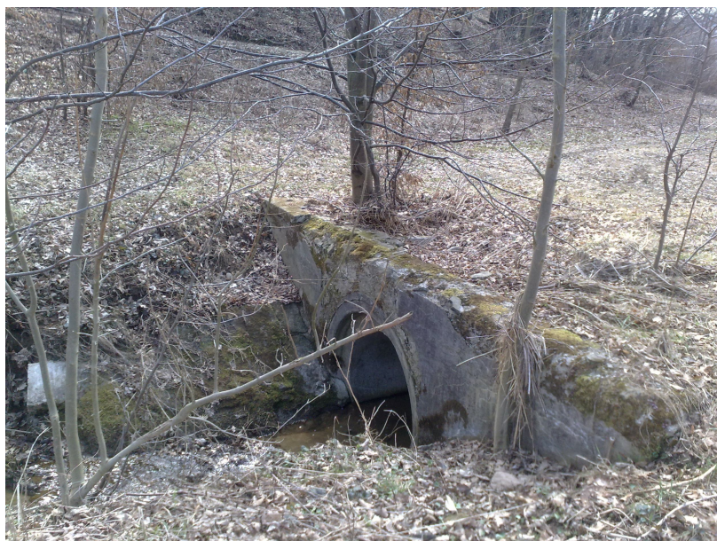
Propustek P5 pod polní cestou C43 na přítoku P1 v profilu 4
