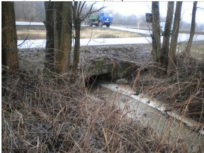
Propustek pod silnicí na přítoku P1 v profilu 4
