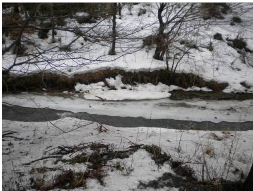
Foto 4: Porušené koryto vodoteče Zašovský potok v ř. km 5,1
