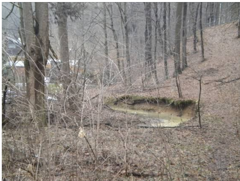
Foto 1: Porušené koryto LB přítoku vodoteče Zhrádek
