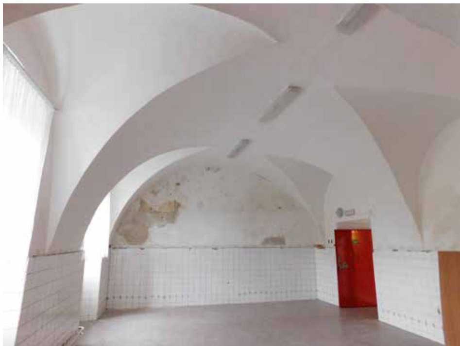
Obr. 6. Interiér jednoho ze sálů v přízemí západního křídla s typickou barokní výsečovou klenbou, krátce po roce 1725. Foto J. Štětina.
