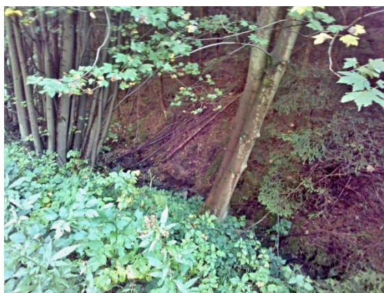
Zahloubené koryto potoka pod hrází
