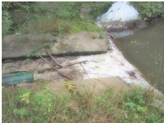
Hráz s bezp. přelivem, těsnící folie
