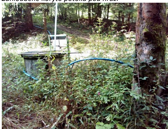
Armaturní šachta na hrázi
