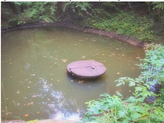
Stávající nádrž, nepřístupný výpust. objekt
