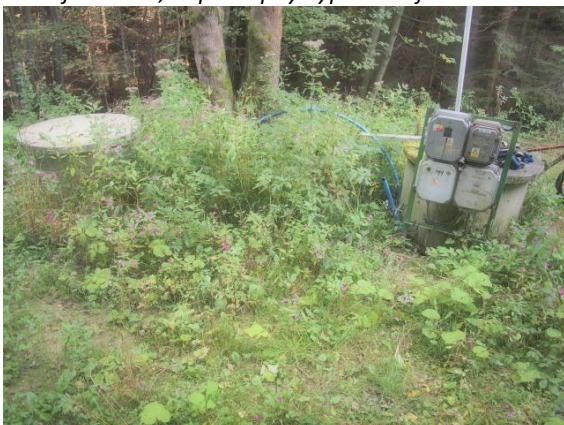
2 armaturní šachty v hrázi
